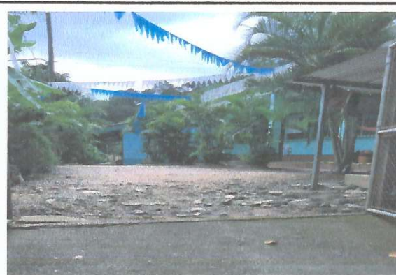
Foto 2: REPARACIÓN DE ESTRUCTURA DEL TECHO DEL PÓRTICO
